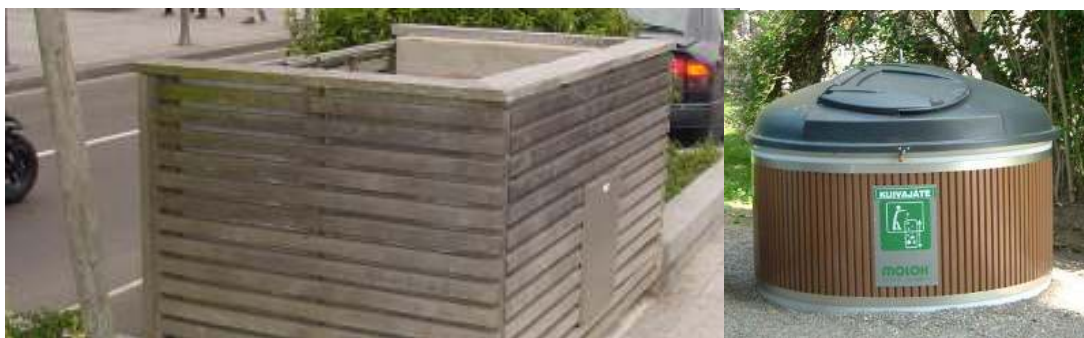
Points d'apports volontaires en entrée de site pour les déchets ménagers, la mutualisation permet d'économiser de l'espace
