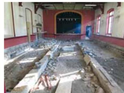
La salle des fêtes, "vieille dame" dont on a célébré le centenaire il y a deux ans, se fait une nouvelle jeunesse. Les travaux ont débuté en décembre par la démolition du plancher, qui sera remplacé par une dalle en béton. Le plafond va également être adapté à l'usage festif des lieux avec une isolation acoustique ; le chauffage amélioré et une ventilation double flux vont aussi être installés. La fin des travaux est programmée pour le printemps 2014.
