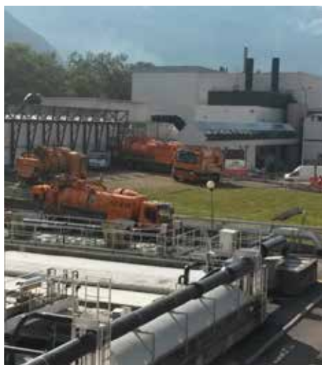
Positionnement des hydrocureuses
